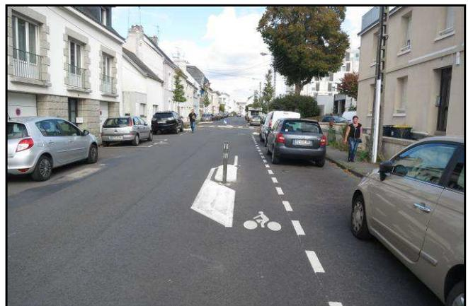
By-pass vélo au niveau d'un rétrécissement en zone 30 (Lorient)
