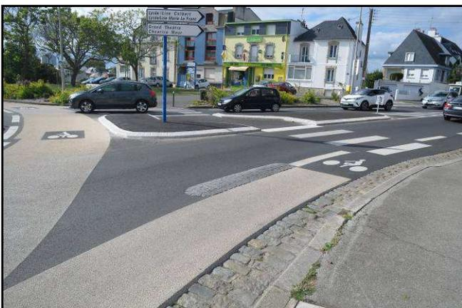
Bon aménagement de bande cyclable dans et à la sortie d'un giratoire : îlots de protection, matériau différent... (Lorient)
