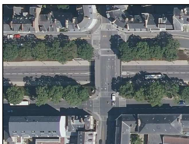
Passage dénivelé réservé aux bus, taxis et véhicules de secours (av. A. Briand, Géoportail)
