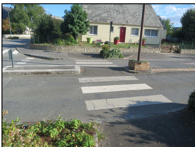
Abaissé de trottoir et îlot central (Chantepie)
