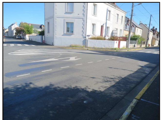
Traversée obligeant les piétons à faire un détour (Saint-Pierre-des-Corps)
